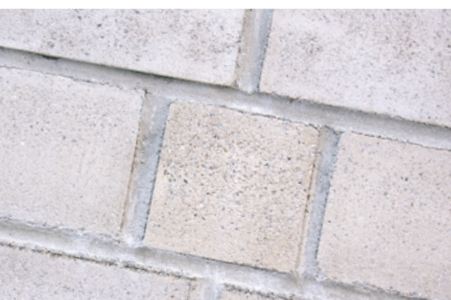
Zabezpieczone preparatem Protectosil® SC CONCENTRATE (nie poddane czyszczeniu)
