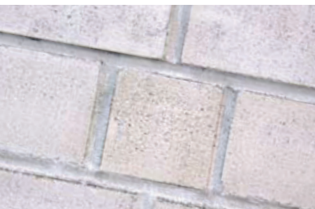
Mit Protectosil® SC CONCENTRATE behandelt (nicht gereinigt)
